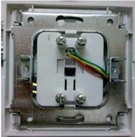
Kod priključnice koju ste kupili, priključni krajevi (viljuškice) modularnog konektora su zaklonjeni ispod poklopca.
