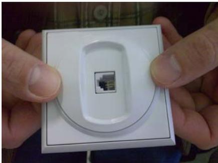
Vratite nazad nosač modularnog konektora blagim pritiskom palčevima na poklopac priključnice.
